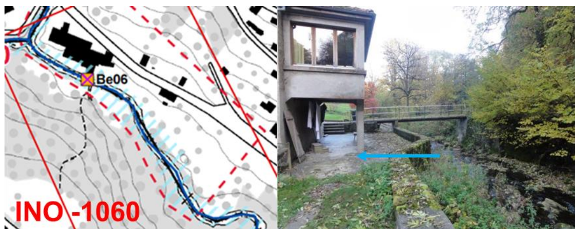
Figure 2: Points de débordement (Be06 - croix rouge) de la Serine à proximité de la scierie (gauche); Sens du débordement en direction de la scierie au niveau du point Be06 rive gauche (droite)
