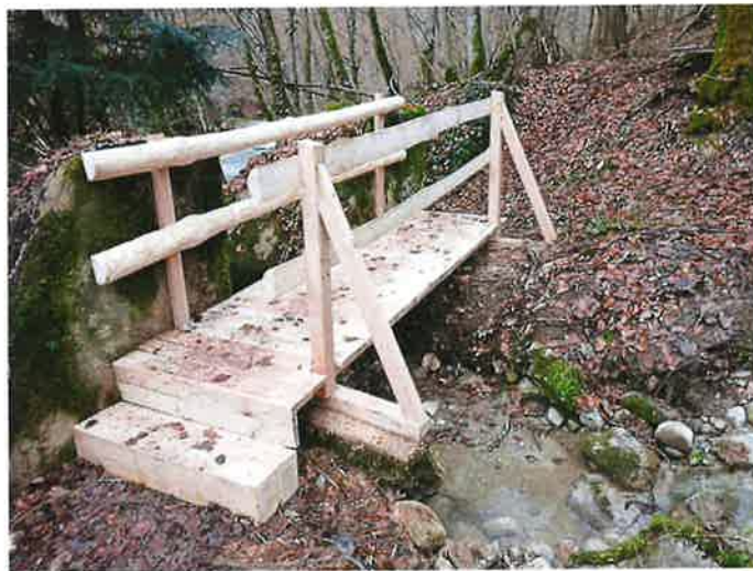
Réfection d'une passerelle du sentier des Toblerones
