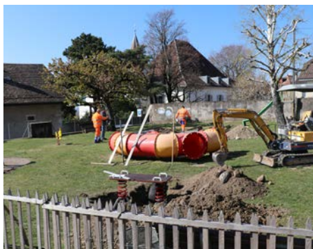
2. Durant le mois d'avril, la voirie a entamé des travaux importants à la place de jeux du temple.
